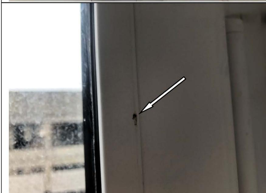
Фото №50. Дефект на профиле оконного блока ПВХ в спальне в квартире.
