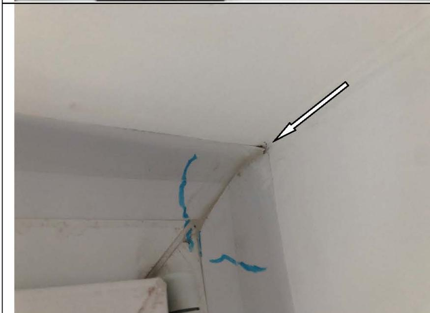
Фото №47. Инфильтрация оконного блока ПВХ в спальне в квартире.
