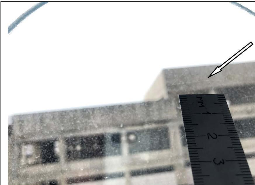
Фото №55. Царапины на стеклопакете оконного блока ПВХ в кухне в квартире.
