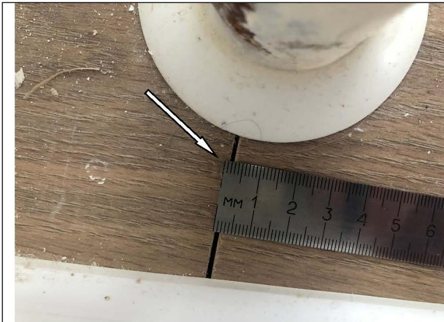
Фото №34. Зазор между досками ламината в кухне в квартире.
