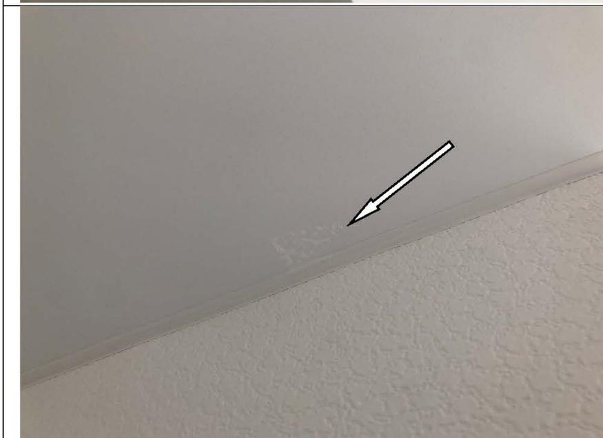
Фото №42. Загрязнения на полотне натяжного потолка в спальне в квартире.
