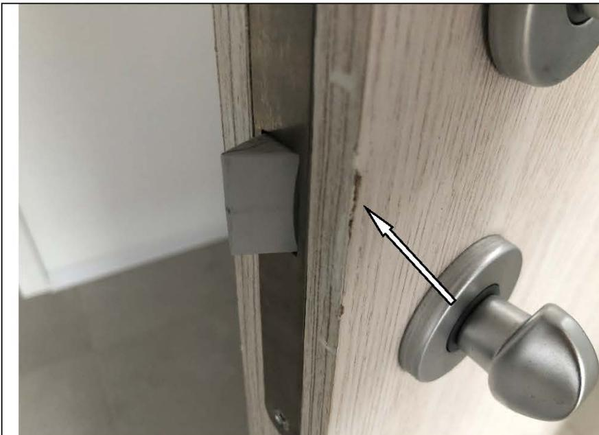
Фото №22. Скол на полотне деревянного дверного блока в ванной комнате в квартире.
