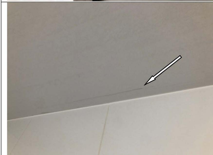
Фото №60. Загрязнения на окрашенном потолке в ванной комнате в квартире.
