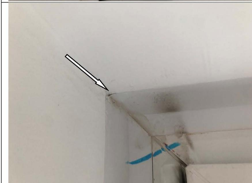
Фото №48. Инфильтрация оконного блока ПВХ в кухне в квартире.
