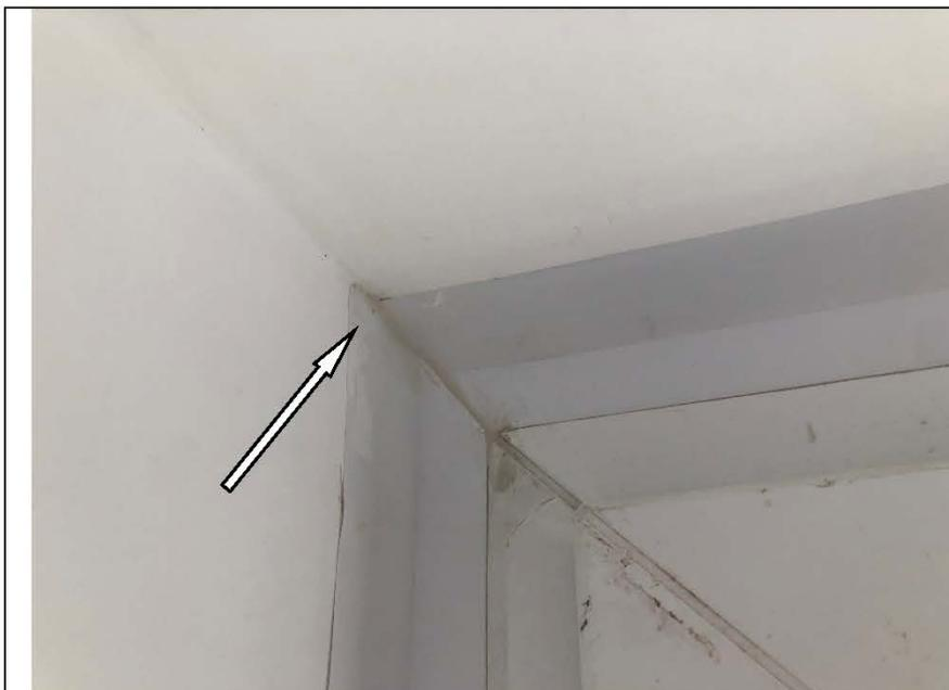
Фото №49. Инфильтрация оконного блока ПВХ в кухне в квартире.
