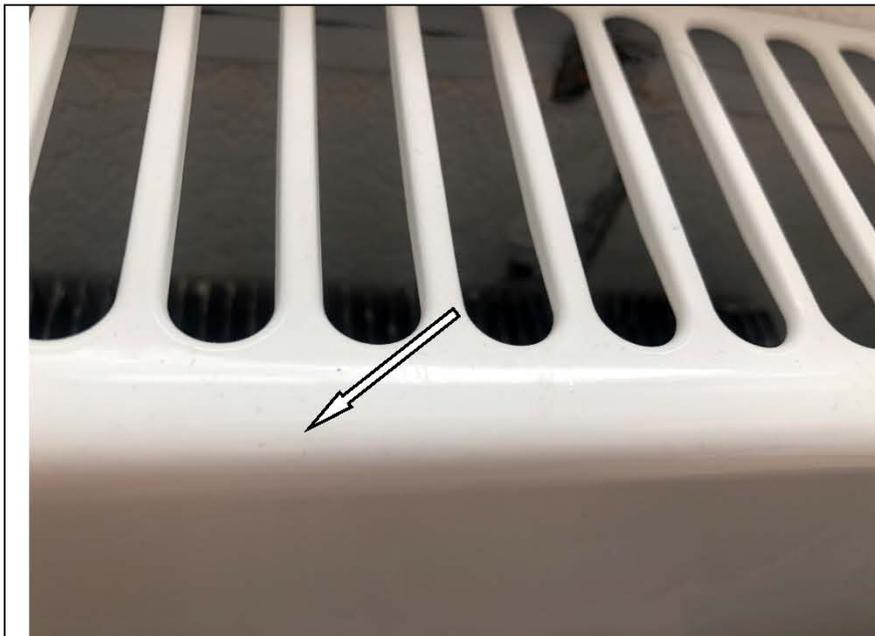
Фото №40. Царапины, загрязнения на кожухе отопительного прибора в кухне в квартире.
