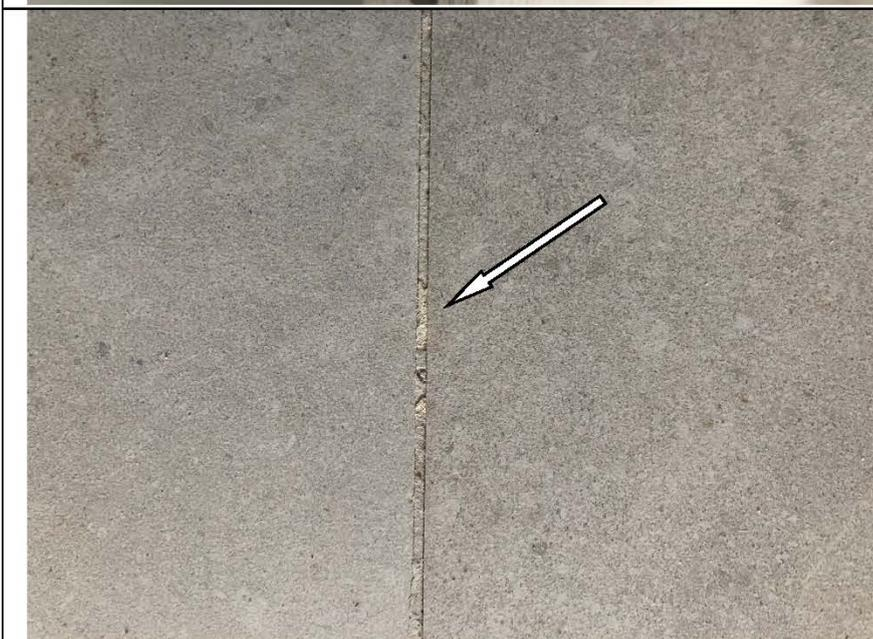
Фото №23. Неровный шов напольной керамической плитки в коридоре в квартире.
