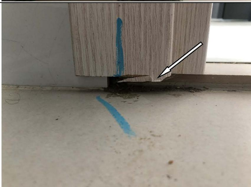
Фото №62. Наличник деревянного дверного блока не достает до напольного покрытия в ванной комнате в квартире.
