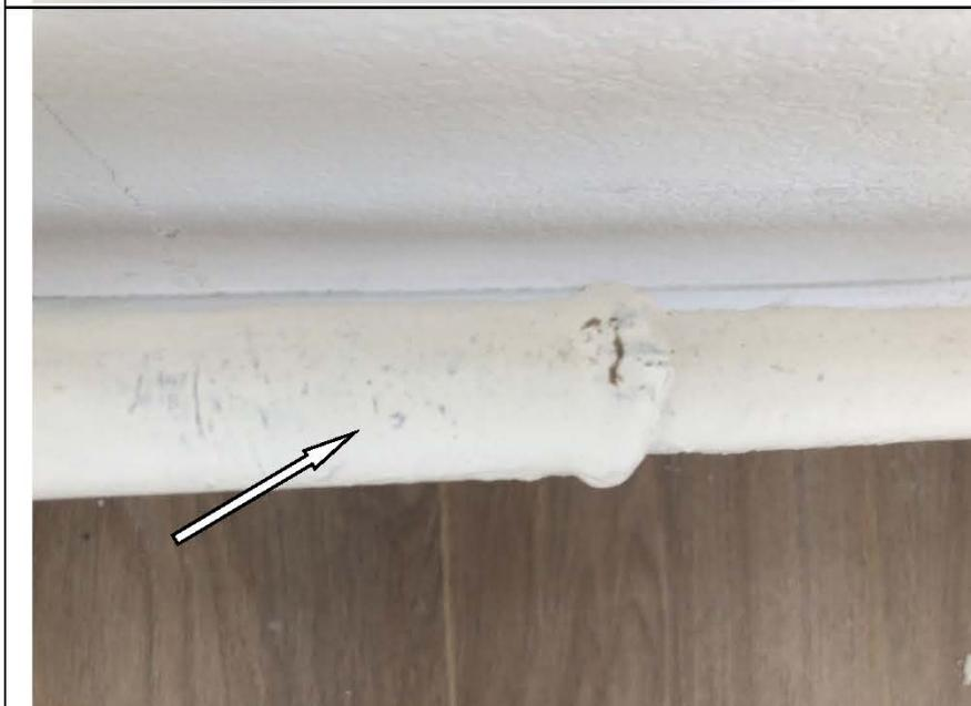
Фото №35. Неровности, сколы на окрашенных трубах отопления в спальне в квартире.
