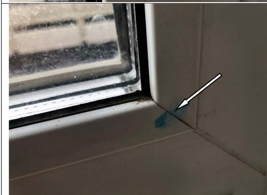
Фото №51. Дефект на профиле оконного блока ПВХ в кухне в квартире.
