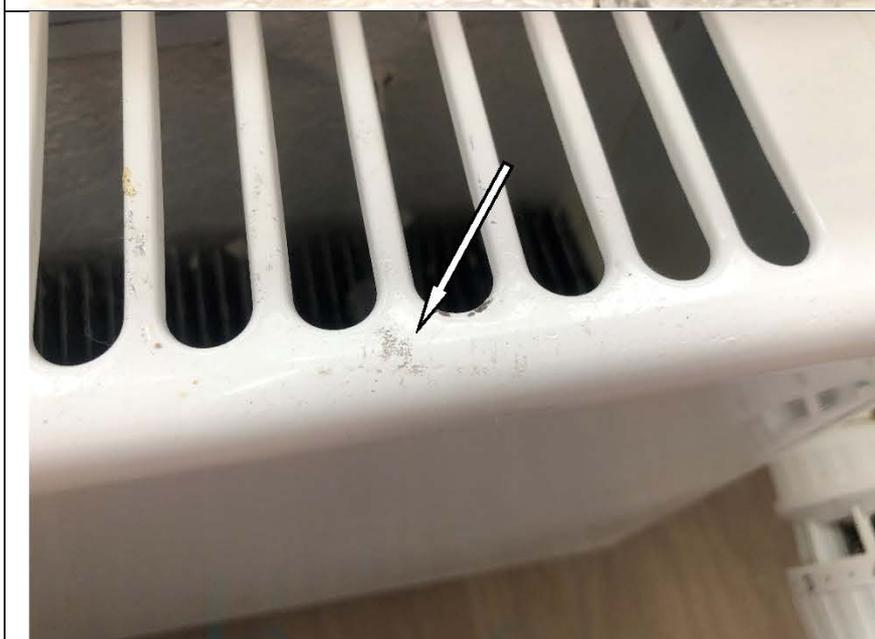
Фото №39. Шероховатости на кожухе отопительного прибора в спальне в квартире.
