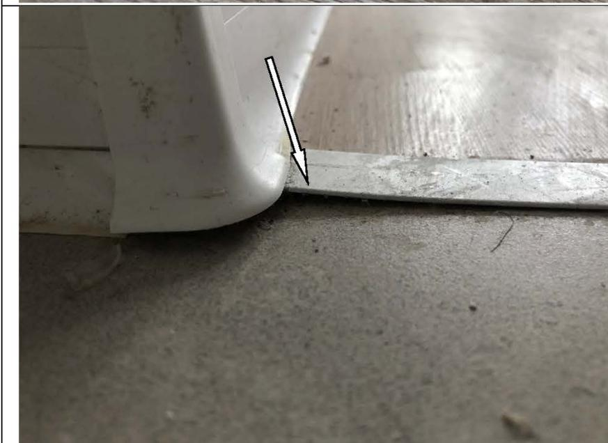
Фото №57. Неплотно прилегает к напольному покрытию напольный металлический плинтус в кухне в квартире.
