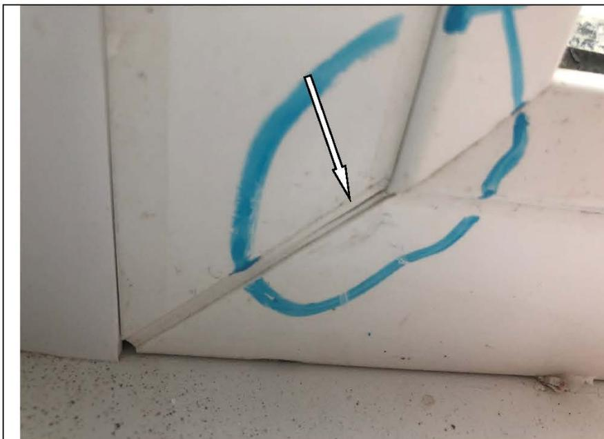
Фото №52. Дефект на профиле оконного блока ПВХ в кухне в квартире.
