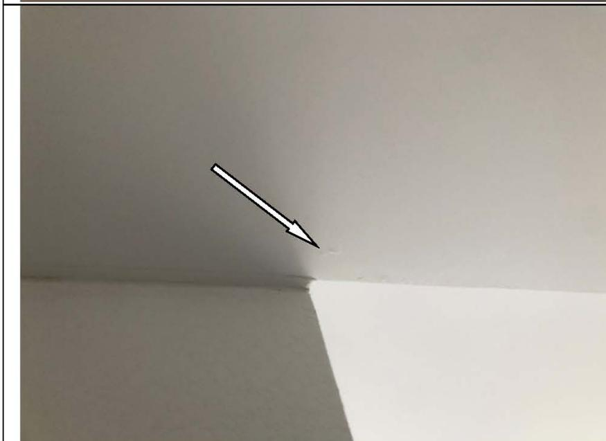
Фото №41. Загрязнения на полотне натяжного потолка в коридоре в квартире.
