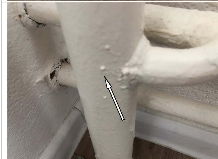
Фото №36. Неровности, сколы на окрашенных трубах отопления в кухне в квартире.
